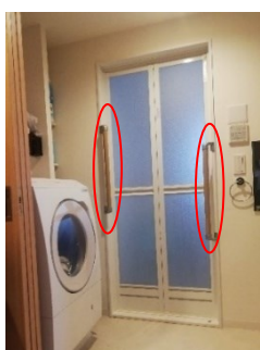
浴室前扉（脱衣所（洗面））の手すり設置事例（分譲住宅）
