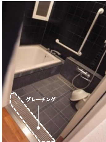
浴室の出入口にグレーチングを設けることで 段差を設けない設計とした事例 (分譲住宅)
